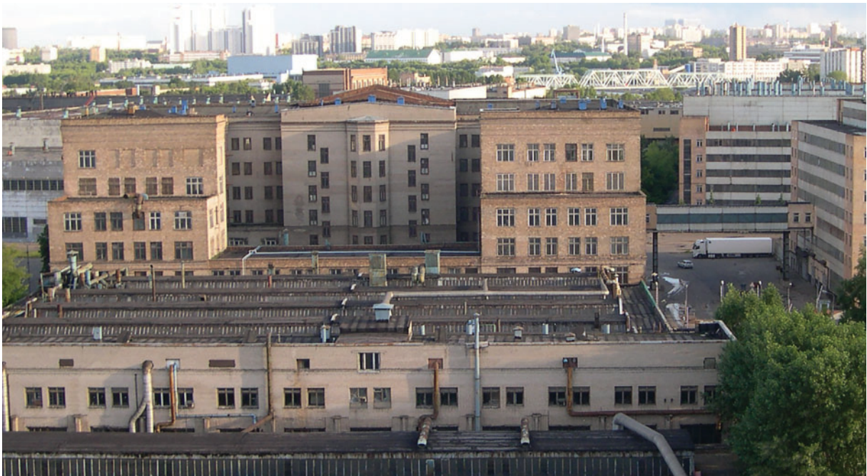
🔺 Вид сверху на Инженерный корпус
