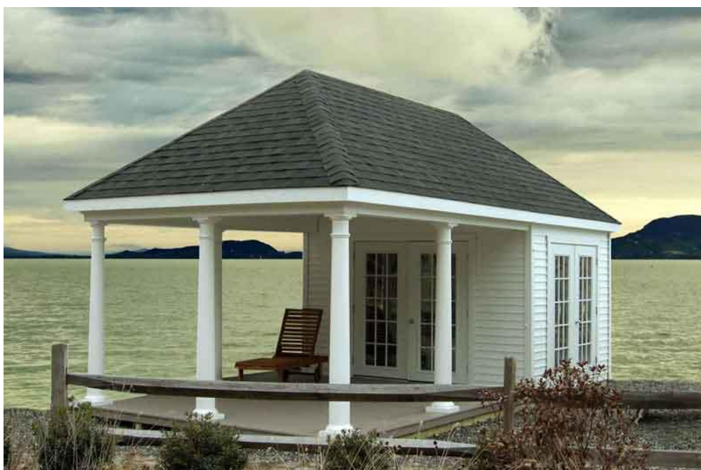
Рисунок 4.3 – Вид здания с четырехскатной кровлей
